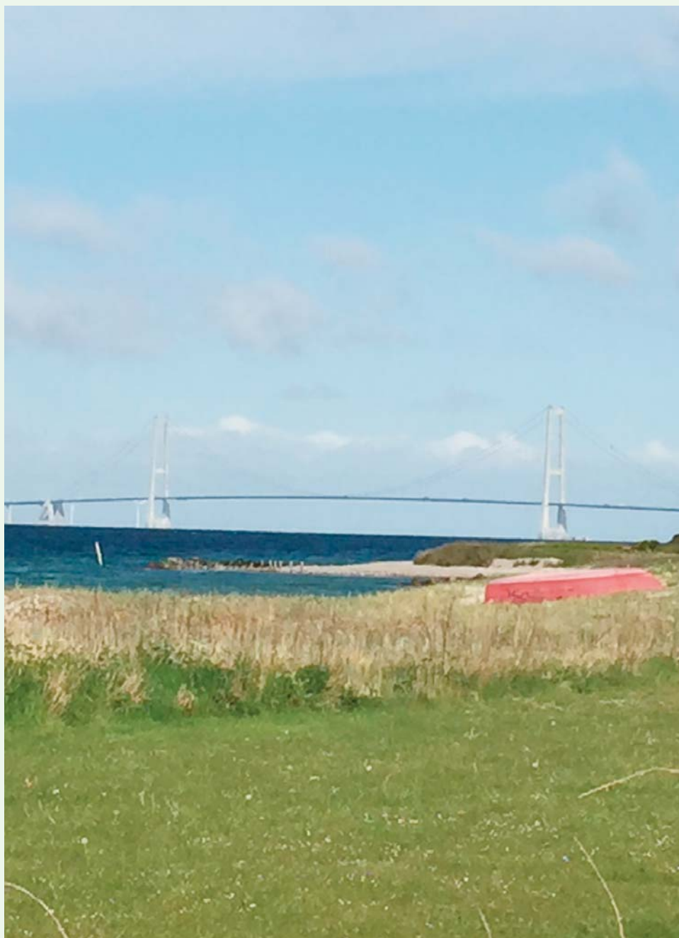
Storebæltsbroen. FotoKaj Ole Rasmussen
