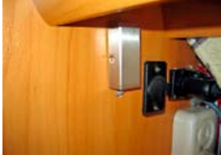
Temperatursensoren monteret i hovedhøjde (uden træk) på ydersiden af vitrineskabet giver en konstant temperaturregulering.
